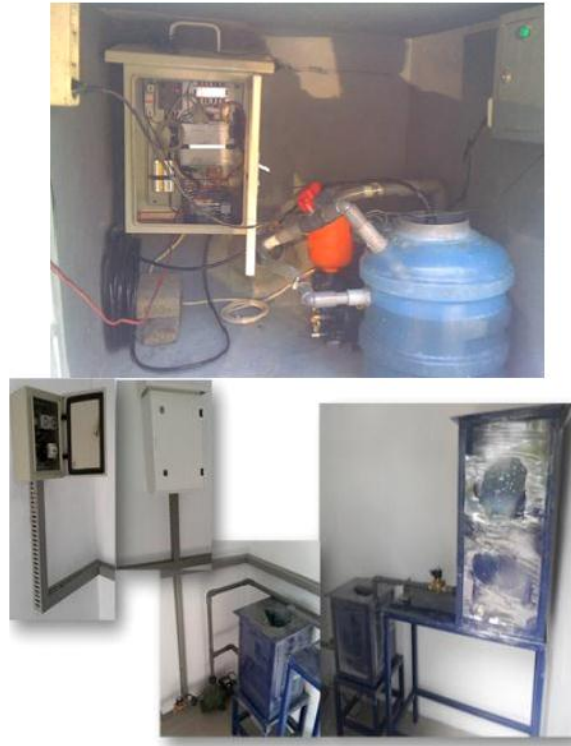
Gambar 1.14 sistem pompa untuk pengambilan sampling air
