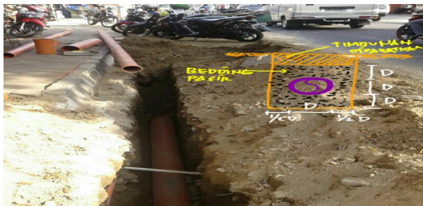
Gambar 11. Contoh Pemasangan Bedding Pasir pada Jaringan
