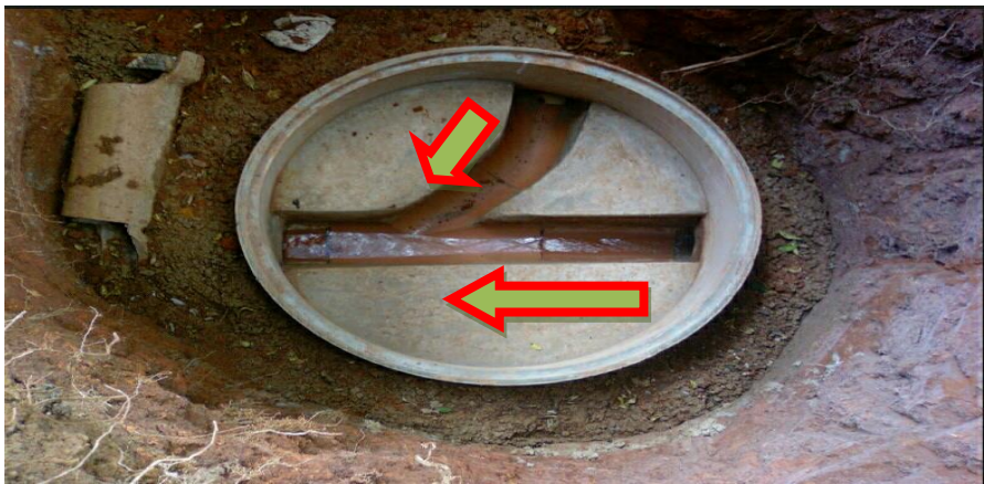
Gambar 7. Contoh Potongan Bak Kontrol ( Precast )
