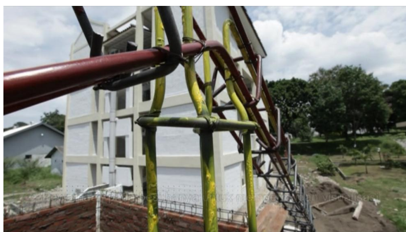
Gambar 52. Hubungan Angkur Pada Gunung-Gunung/ Ampig
