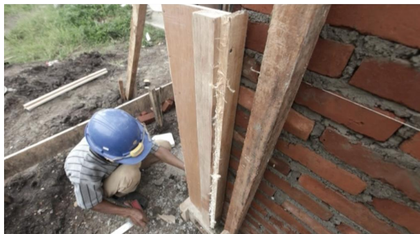
Gambar 55. Pemasangan Cetakan/ Bekisting Untuk Kolom
