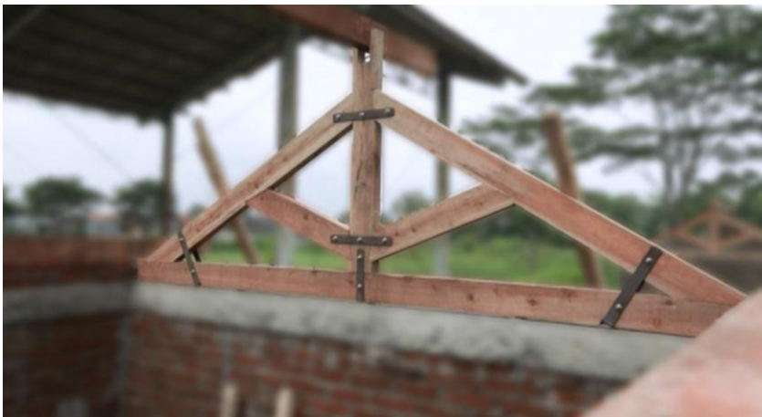
Gambar 28. Kuda-kuda Kayu Dengan Pengikat Plat Baja
