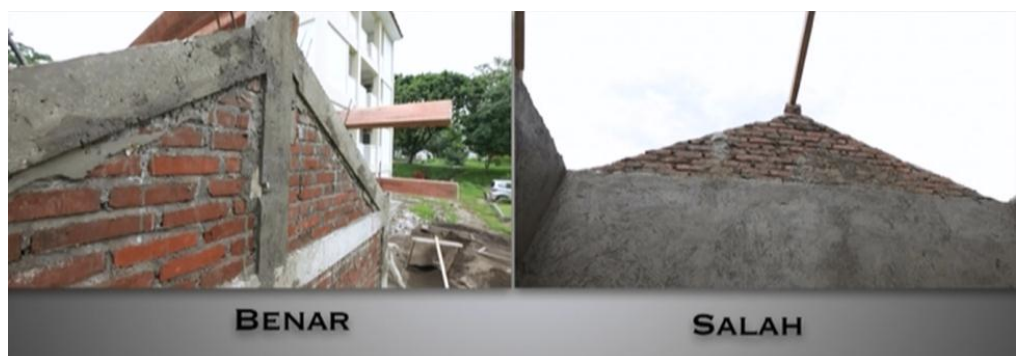
Gambar 32. Gunung-Gunung/ Ampig
