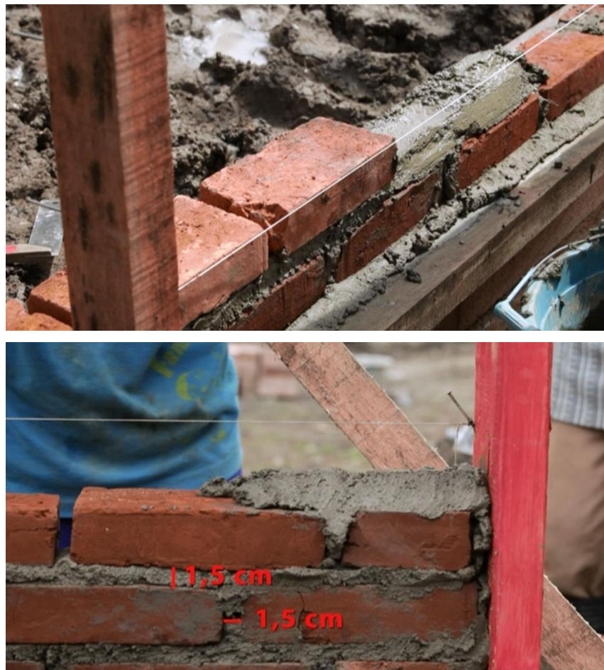
Gambar 41. Proses Pemasangan Batu Bata Untuk Dinding
