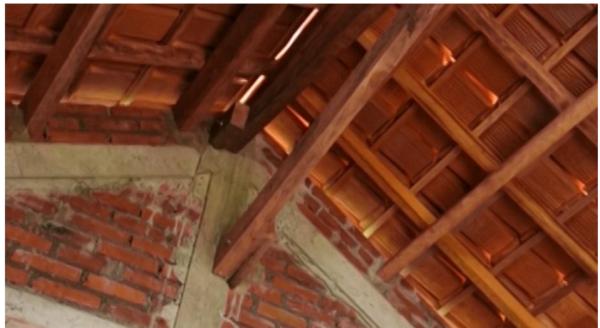
Gambar 37. Pertemuan Antara Ikatan dengan Gunung-Gunung/ Ampig
