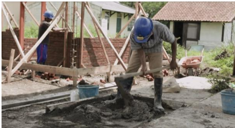
Gambar 8. Proses Pencampuran Mortar
