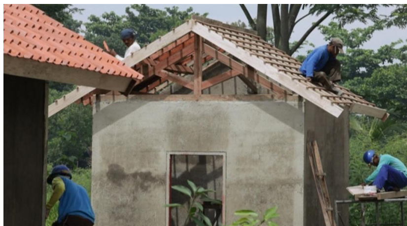
Gambar 27. Kuda-kuda Kayu Pada Atap Rumah Tinggal
