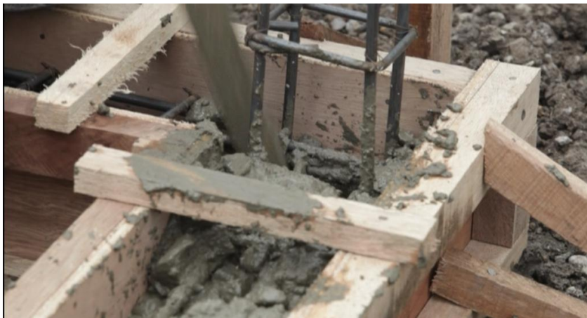
Gambar 58. Pengecoran Balok Pengikat/ Sloof
