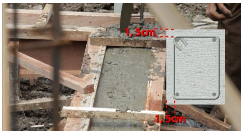
Gambar 19. Balok Pengikat/ Sloof
