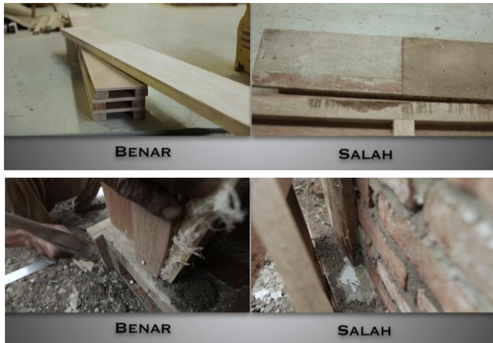
Gambar 54. Kualitas Cetakan/ Bekisting
